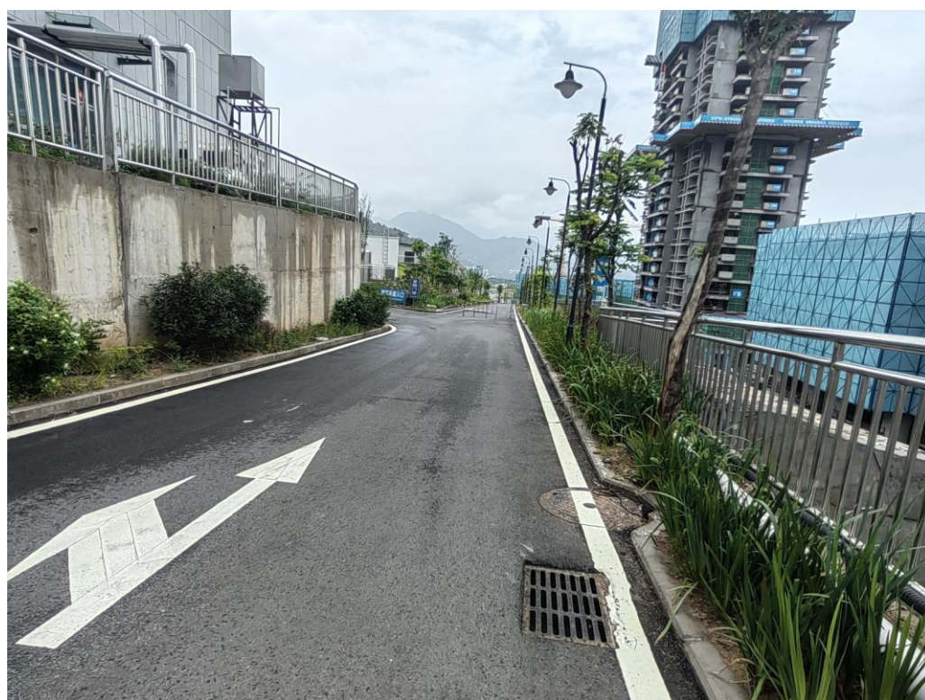
项目区内道路排水设施
