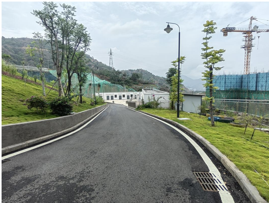
项目区门诊楼周边道路排水及集中绿化
